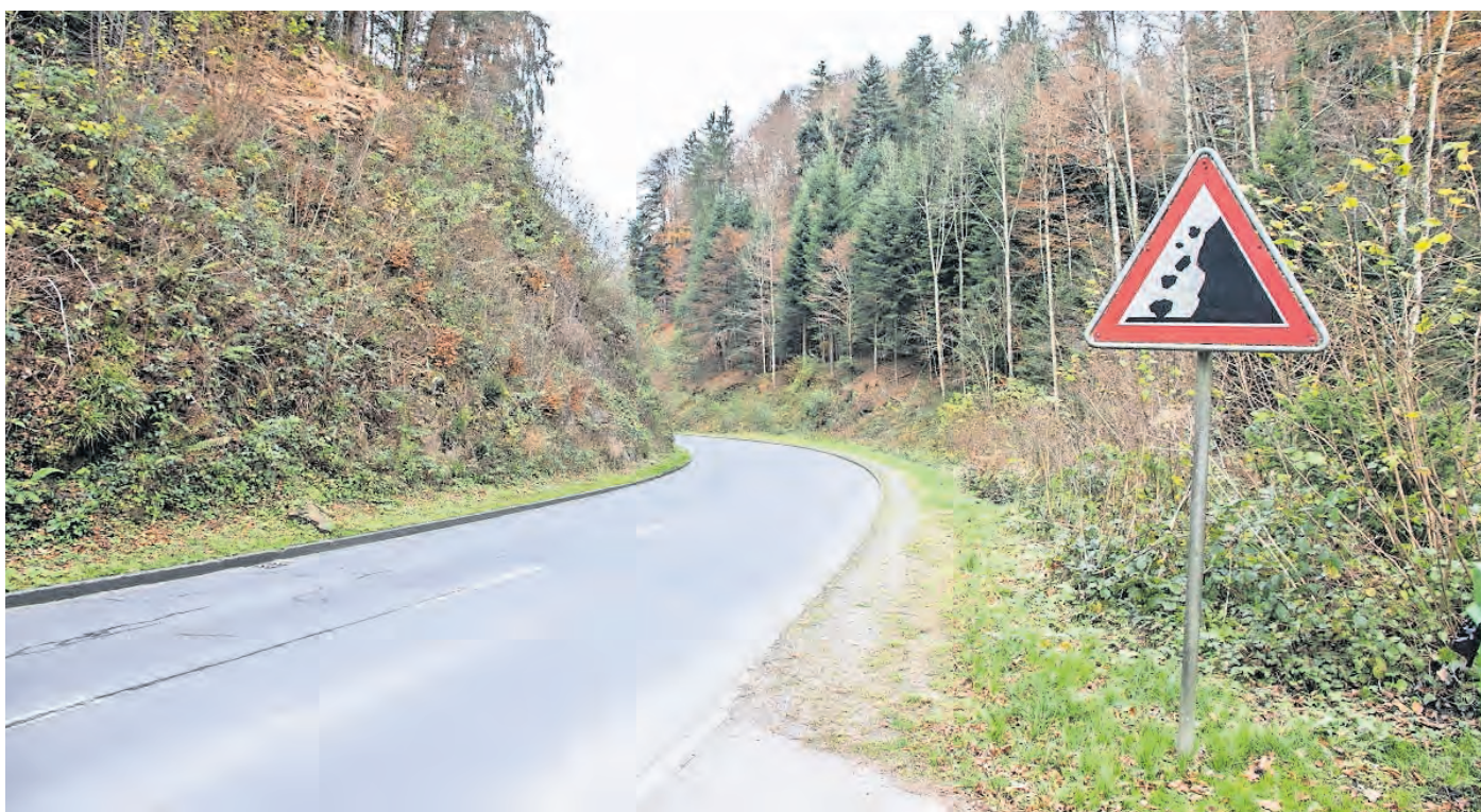
Steinschlaggefahr: Im unteren Teil der Meggerstrasse wird eine Felswand um 3.50 Meter abgetragen, was auch die Übersichtlichkeit verbessern wird.
