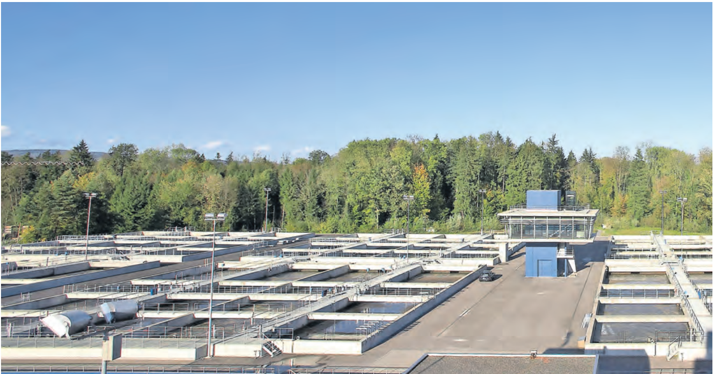
Die Abwasserreinigungsanlage Buholz in Emmen: Hier ist auch Adligenswil angeschlossen.
