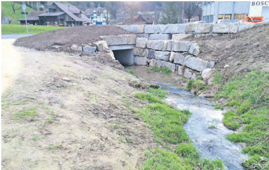
Im Gebiet Stuben hat die Gemeinde nach dem Unwetter vom 7. Juni 2015 umfassende Sanierungsmassnahmen realisiert.
