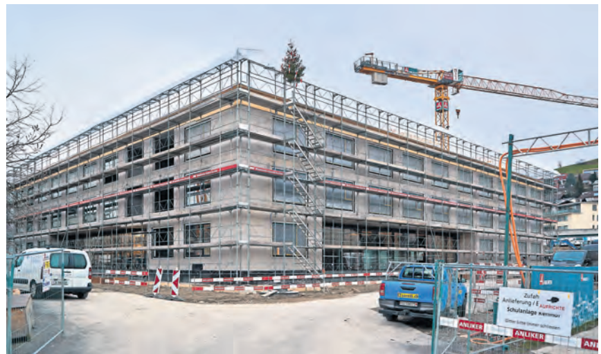
Der Richtbaum auf dem Dach des Pflegezentrums zeugt vom Baufortschritt.
